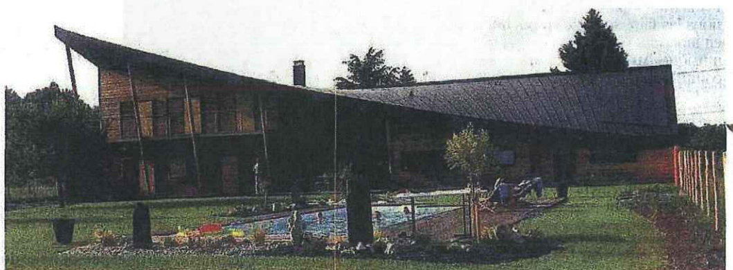
LA PLUS FANTAISISTE. Région du Mans (Sarthe). Vague solaire, près de 2 000 €/m 2 (Gilles Poulain Architecte). Une vraie fantaisie architecturale, conçue en bois (70 %) et en mono-mur de terre cuite (30 %) sur près de 280 m 2 habitables. Le toit en hélice a été pensé pour combiner apports solaires passifs (la grande verrière) et actifs (panneaux photovoltaïques).
